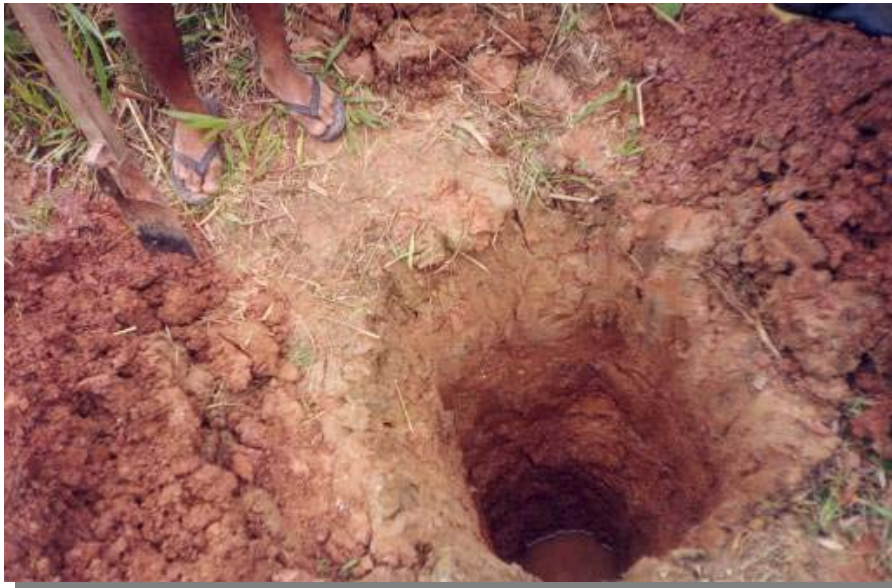
Fig. N° 4.6: Vista de la calicata en el Km. 207 (Formación Iparuro).
